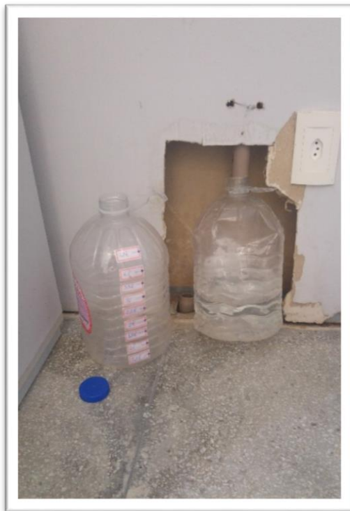
Figura 04 – Medição do bloco administrativo (dreno na sala dos terceirizados) Fonte: Acervo pessoal
